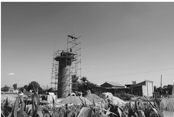
今年,宁县共实施集中供水工程14处,新打小水井3500眼,预计到2016年末,自来水入户率将达到100%。图为宁县焦村镇半个城村一处在建水塔。
